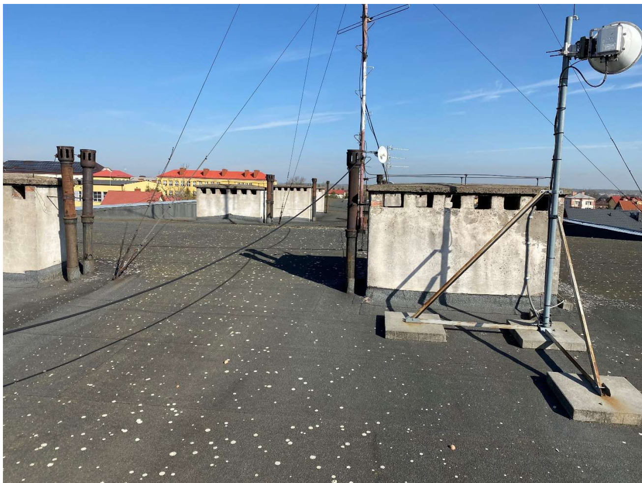
Zdjęcie nr 6 – widok ogólny dachu
