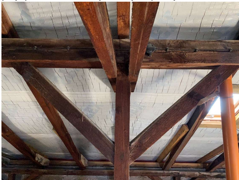
Zdjęcie nr 2 – rozwiązanie węzła na połączeniu słupa i jętki
