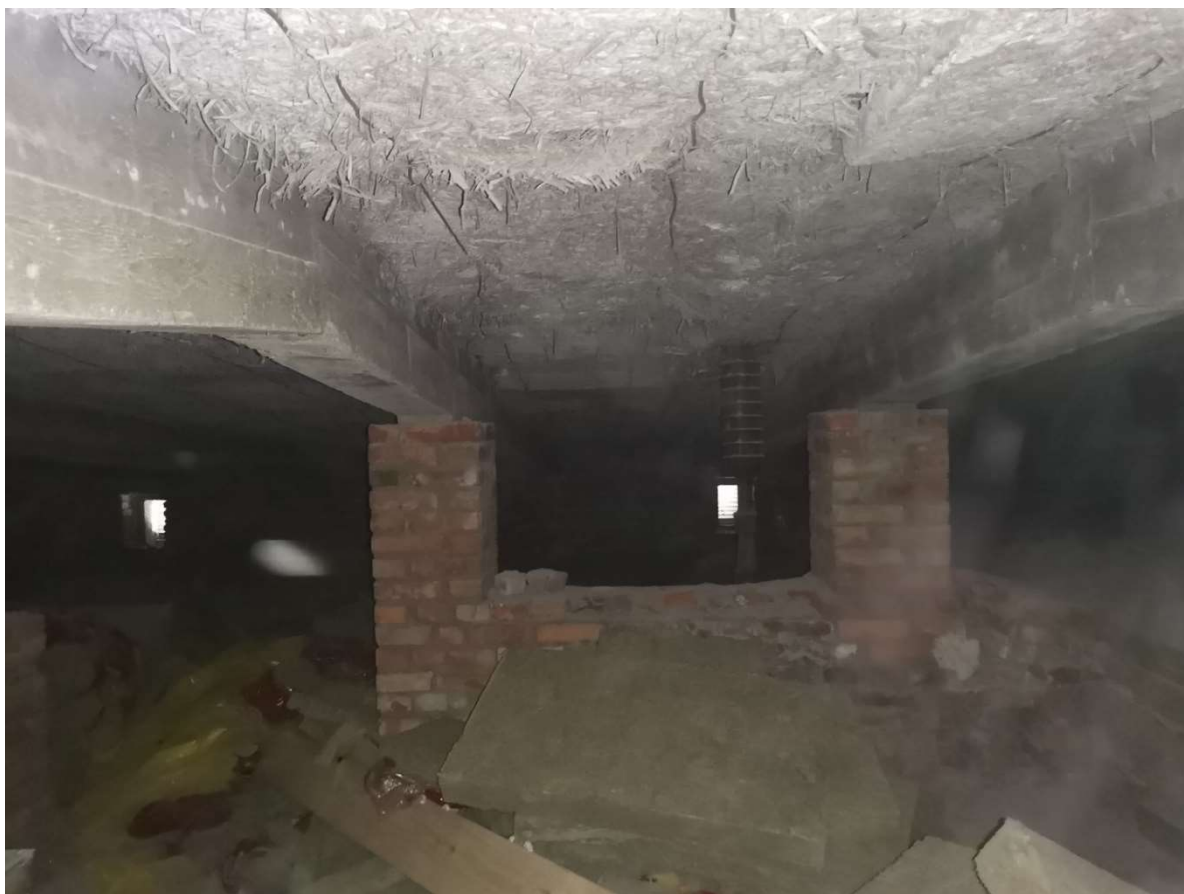
Zdjęcie nr 5 – widok dachu od spodu z widocznymi żebrami żelbetowymi i ociepleniem płytami PDC
