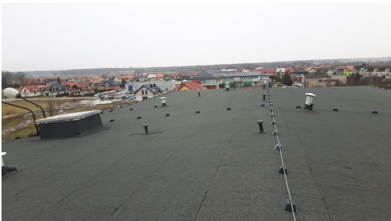
Zdjęcie nr 4 – widok ogólny dachu
