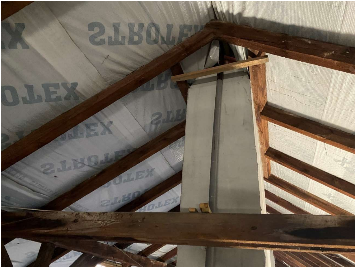
Zdjęcie nr 3 – rozwiązanie węzłów w kalenicy wokół komina
